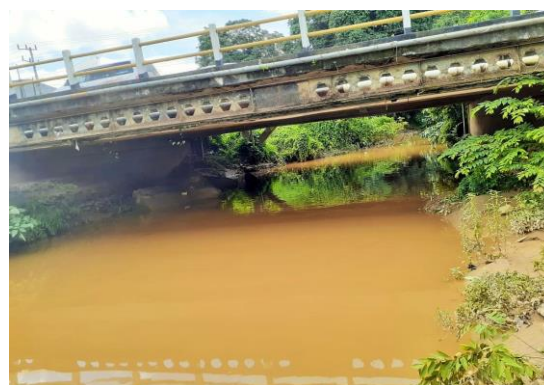
Gambar -2: Kondisi eksisting Sungai Wanggu ( 4^{\circ}01'35.2''\text{S}-122^{\circ}30'23.4''\text{E} )
