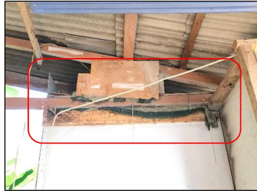
**Gambar 4:** Cerobong yang ditutupi oleh handuk untuk *recovery* uap merkuri
